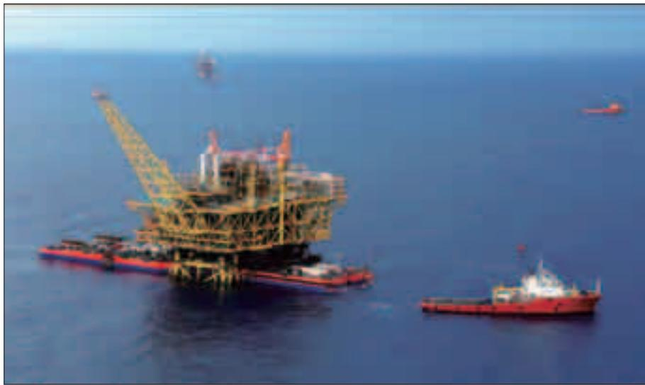
图 6-11 荔湾 3-ICEP 组块浮托安装作业现场
